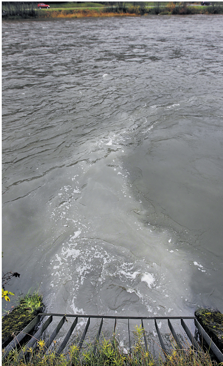
Bare rør: Regnvannsoverløpet ved Fredlybekken pumpestasjon er en stor forurensningskilde med utslipp av kloakk rett i Nidelva. Utslipet er kommunens største punktutslipp av kloakk. Nå vil bekken bli lagt i rør for å fjerne forurensning og sikre mot flom. Foto: GLEN MUSK
