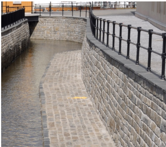
Figur 32. I kanal kan det legges inn ulike tiltak for å variere strømningsforholdene og for å samle vannet ved lav vannføring. Det vil også bidra til bedret vannkvalitet og gi en variert opplevelse av vannet.
